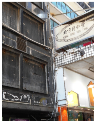
「民主派」が破壊した中国商店 (2019年11月撮影)
