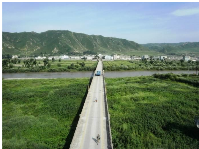
橋の向こうは北朝鮮の建物がみられる。
